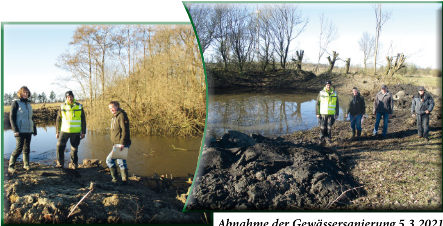
Abnahme der Gewässersanierung 5.3.2021
