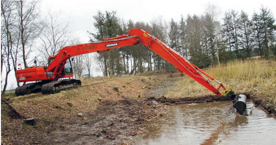
Langarmbagger im Einsatz
